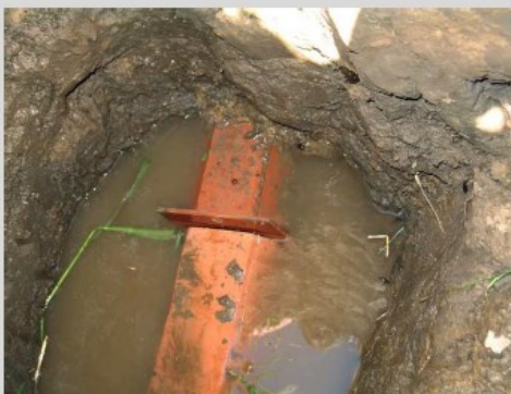
Obr. 4 / Vlevo: Účinek kombinace zarůstání průtočného profilu kořeny bylin a zanášení splaveninami z drenážní vody (foto: M. Čmelík) Vpravo: Příklad instalace záslepky (případně clony) na drénu, kdy je PVC záslepka vložena do stávajícího drénu z pálené hlíny, průměru 0,13 m. (foto: M. Soukup)
