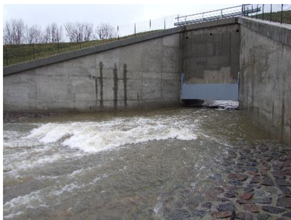
Obr. Ilustrační fotografie plně migračně prostupné spodní výpusti (poldr Žichlínek).
