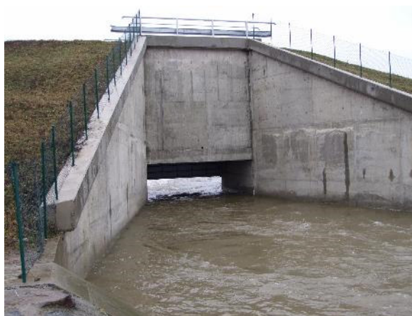
Obr. Ilustrační fotografie plně migračně prostupné spodní výpusti (poldr Žichlínek).
